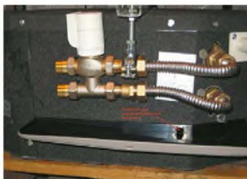
Поддон для сбора конденсата (внешний) и запорно-регулирующий узел смонтированы на кассетном фанкойле
